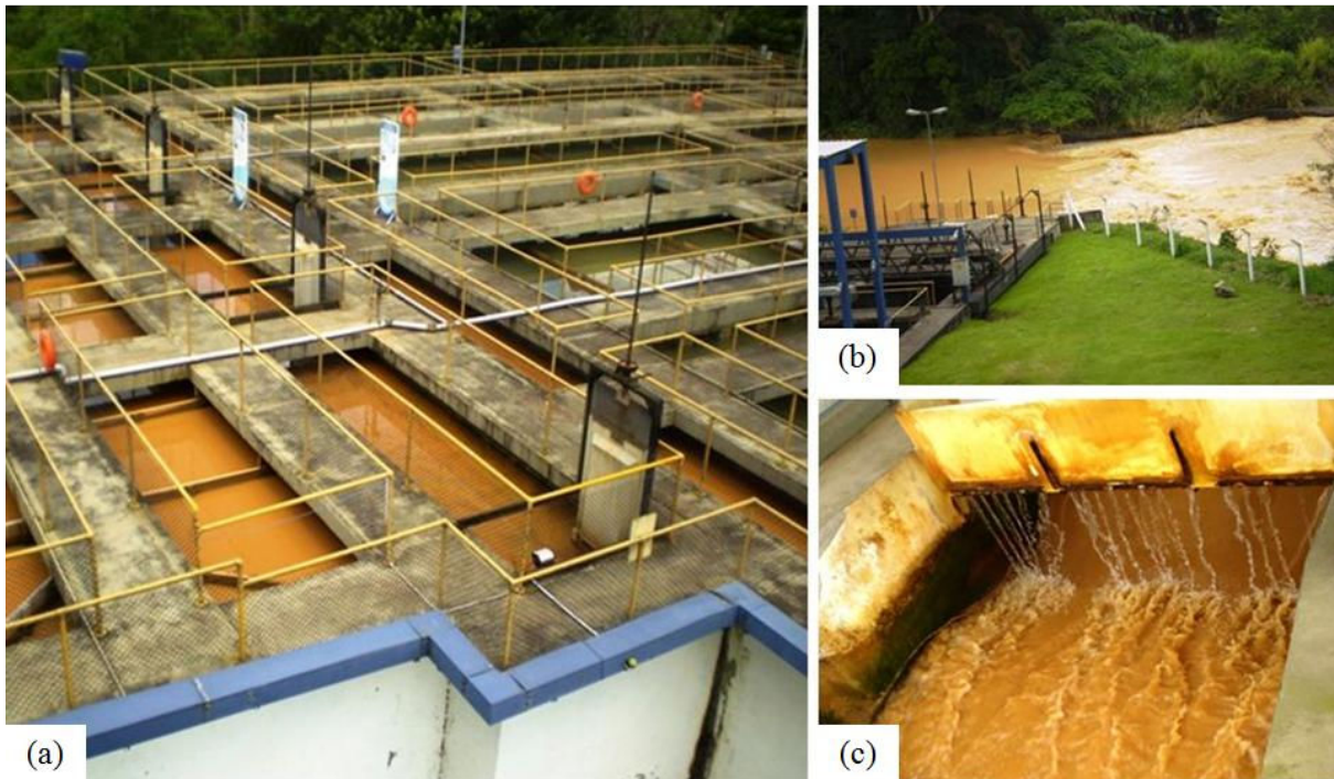
Figura 5 – Alta turbidez nas instalações da ETA: (a) Floco decantador; (b) Captação e (c) Calha Parshall.
